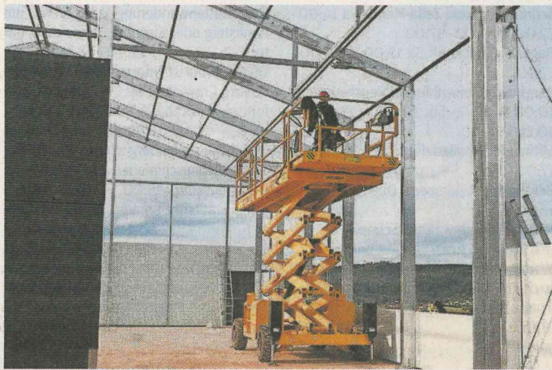
Die Arbeiten an den Hallen stehen kurz vor dem Abschluss.
